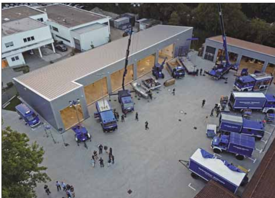
Blick auf der Freisinger Fuhrpark nach Einweihung der neuen Unterkunft 2018. Einige Fahrzeuge sind inzwischen durch Nachfolgemodelle ersetzt.
